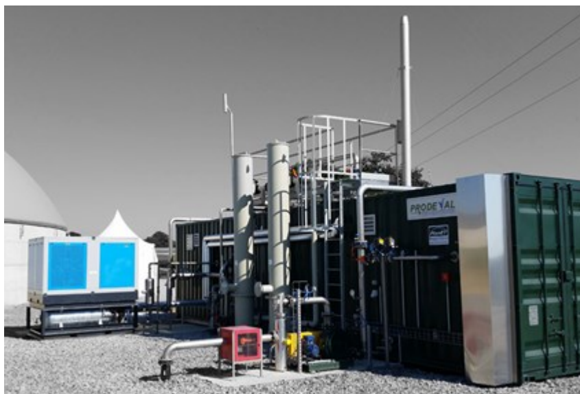
Fig. 13 – Particolare container alloggiamento upgrading
